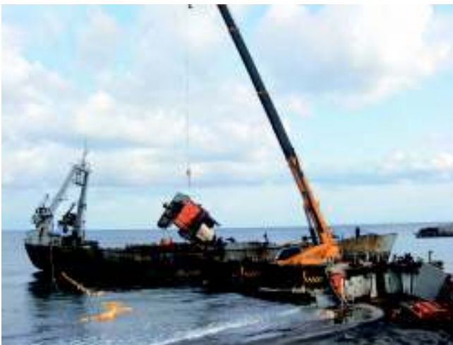
【解体作業 H20・10】
