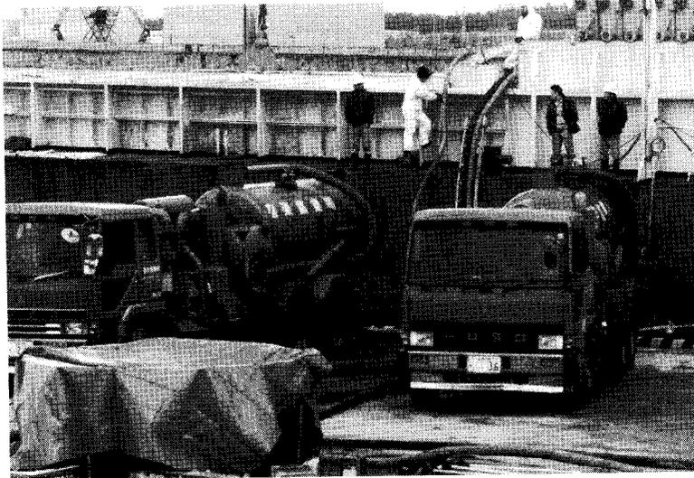
写真9 第1ピットから寿号への油の移送
