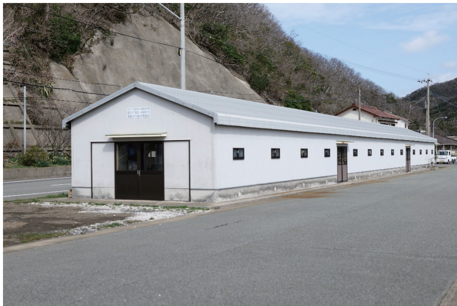
図 2.7 島内に整備されている共同倉庫
