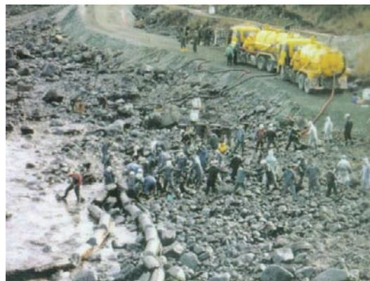
写真24 強力吸引車が仮設道路から直接回収
