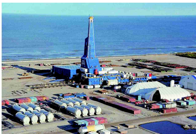
陸上掘削基地と掘削の様子（陸上から11kmのパイプを延ばして原油をくみ出します。）
