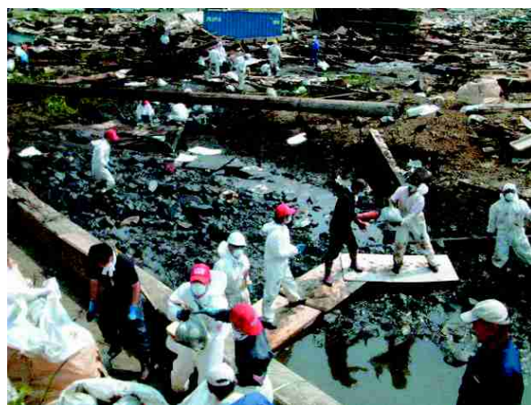
写真 19 土嚢のリレー搬出フレコンへ入れる
