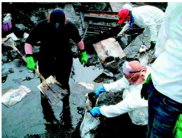
写真 16 油の濃い表層土のかきとり
