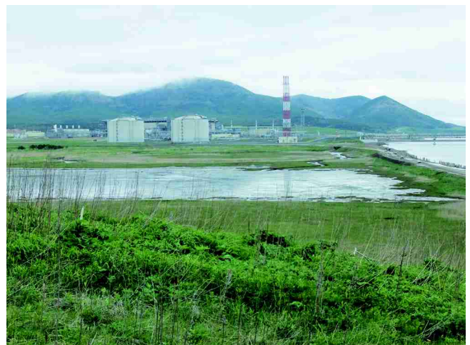
LNG液化プラントの全景
