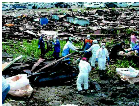
写真 17 作業状況 フレコンに入らない大きさの油汚染木材、作業に邪魔な物を集積
