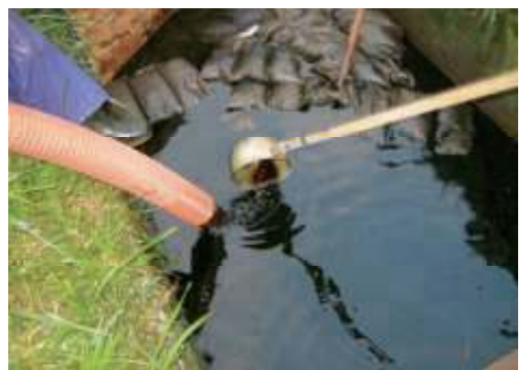
写真11 水路に溜まったA重油 事例18 水路にコンパネを吊るし(OF代用)油層厚を作り、吸引車と油吸着材、柄杓で回収した。このコンパネは2カ所設置し、この間の油をまず回収、当初10cmの油厚があった。水路から川に流れた油は、200m程で海に出た。
