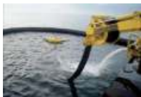
油回収装置による回収
