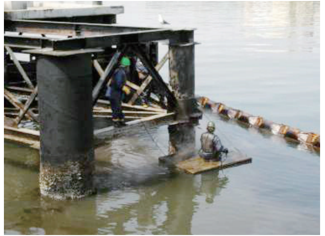
写真4 高圧洗浄機による洗浄
