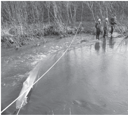
写真7 オイルフェンスによる堰
