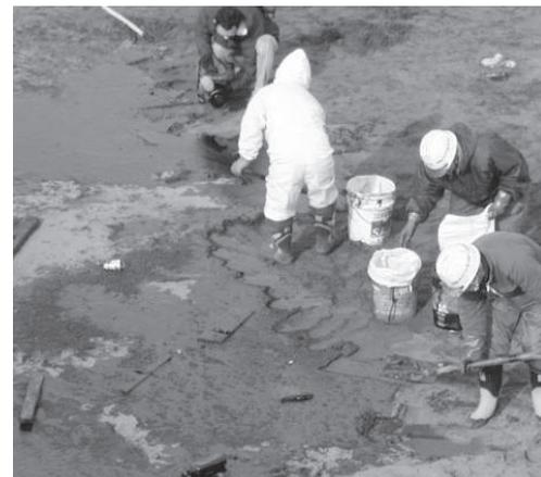
写真5、6 海浜回収 砂を少なく回収に努めた C重油 100トン (H16北海道石狩)
