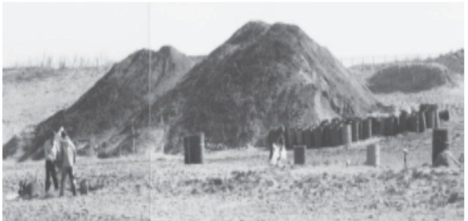
【ナホトカ号の例】平成9年1月8日夜、石川県加賀市の塩屋海岸に大量の油が漂着、翌朝バックホー等の重機数十台により油のかき集めが行われた。これらの油は、穴を掘って埋めたり、又は山積みされたが、重機により幾度となく移動され、かき混ぜられ油と砂が均一に混じり合ってしまった。このため、後日多くのボランティアの手作業により油分の分別を行った。回収された砂は約5,200トン、後日これらは焼却又は管理型埋立地で処理された。この砂浜では、その後数年間、深刻な海岸浸食が進行していた。
