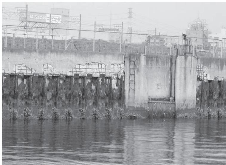
図7 鋼矢板の腐食・コンクリートの劣化
