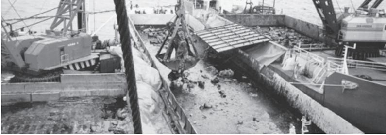
写真 12 回収された廃棄物の船舶による輸送・陸揚げ (ナホトカの事例)
