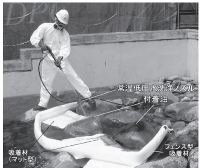
図 10 吸着材による剥離した油の包囲・回収の例
