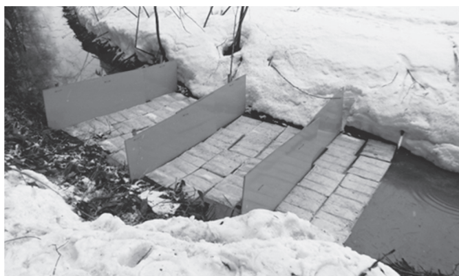
写真6 コンパネ板による堰 幅2m、水深30cm、30cm/s 川底に15cmすき間を開けた
