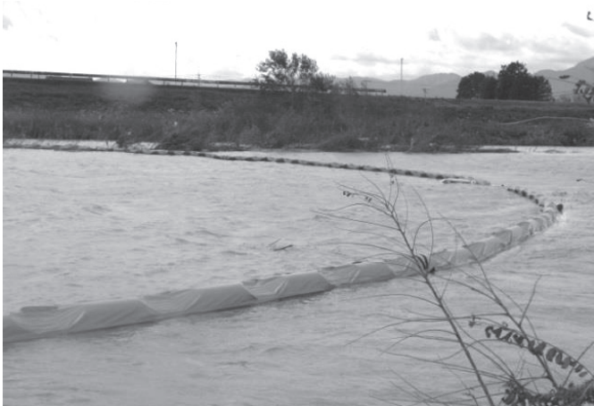
写真4 野村橋に設置されたオイルフェンス（10月25日撮影）
