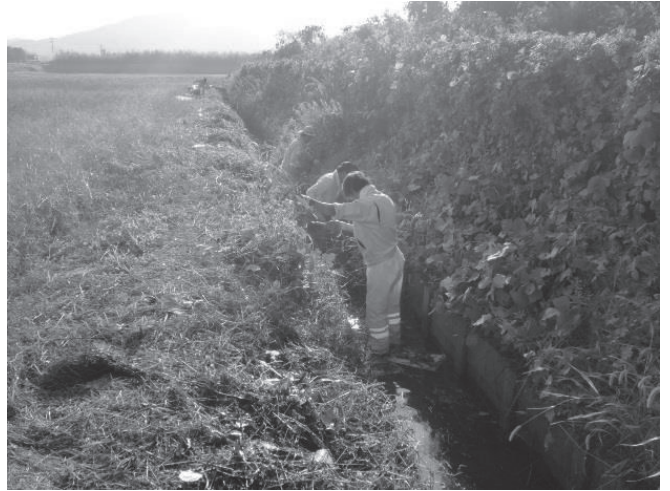
写真7 水路の除草作業の様子
