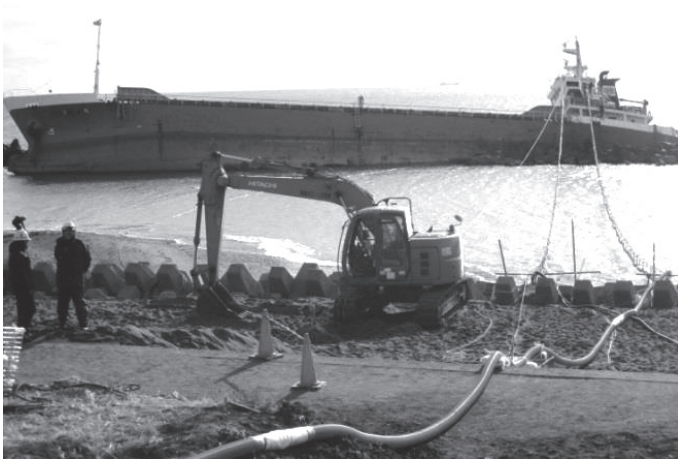
写真3 油の抜き取り
