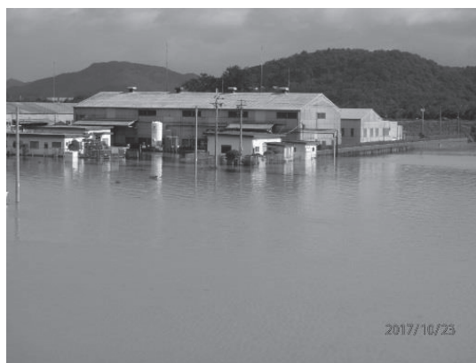
写真1 冠水した工場と周辺の農地（10月23日）
