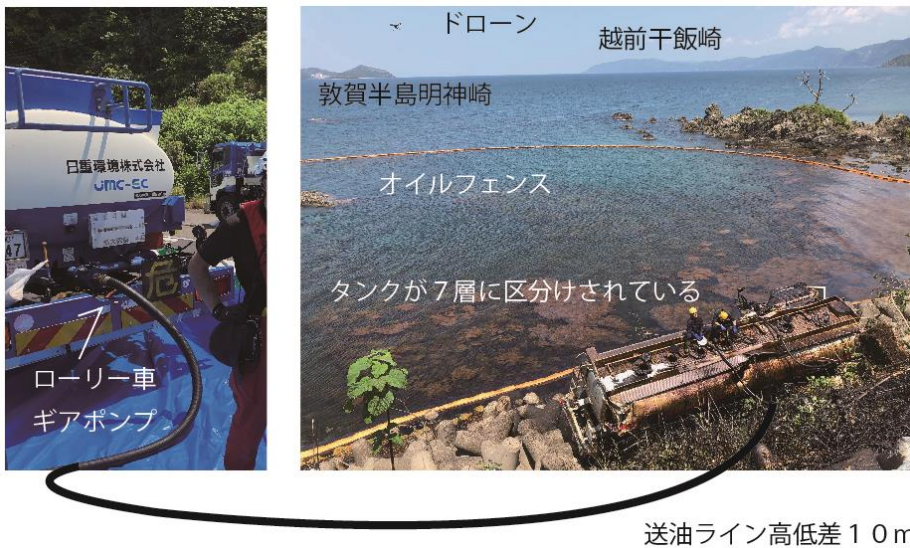
図5 油の抜き取り作業
