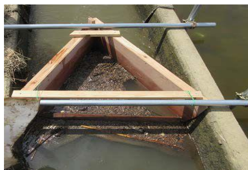
写真 14 簡易堰 流れがある状態
