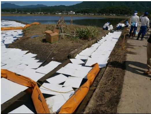
写真 17 意味のない油吸着材の使用 大量のごみの発生となる
