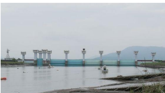
写真 3 六角川河口堰
