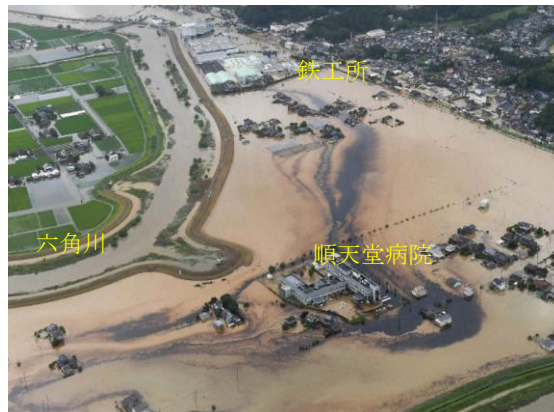
図4 鉄工所から流出した油
