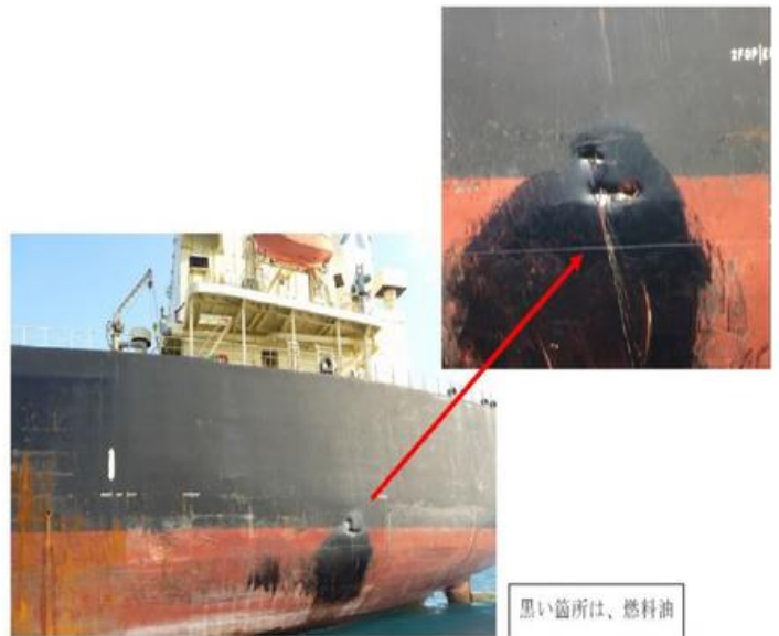
写真2 A船の左舷船尾部の破口状況
