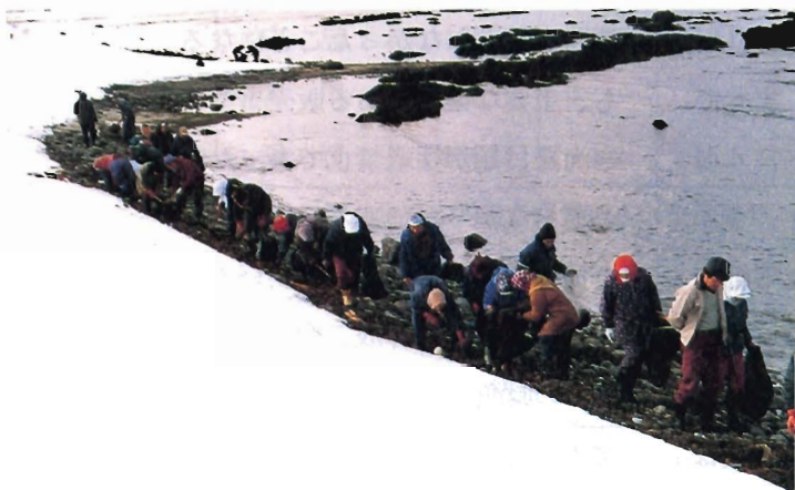
厳冬の中での油濁被害復旧作業 (昭和59年1月 青森県佐井村漁協)
