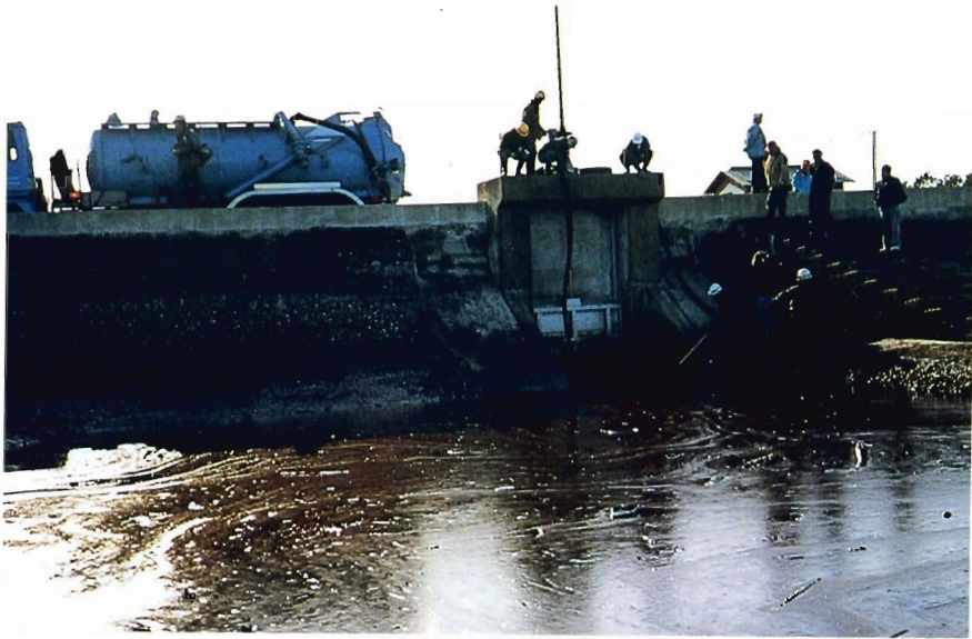
平成2年12月17日、千葉県袖ヶ浦沖ワールドビクトリー号原油流出事故。バキュームカーにより油を吸上げている風景
