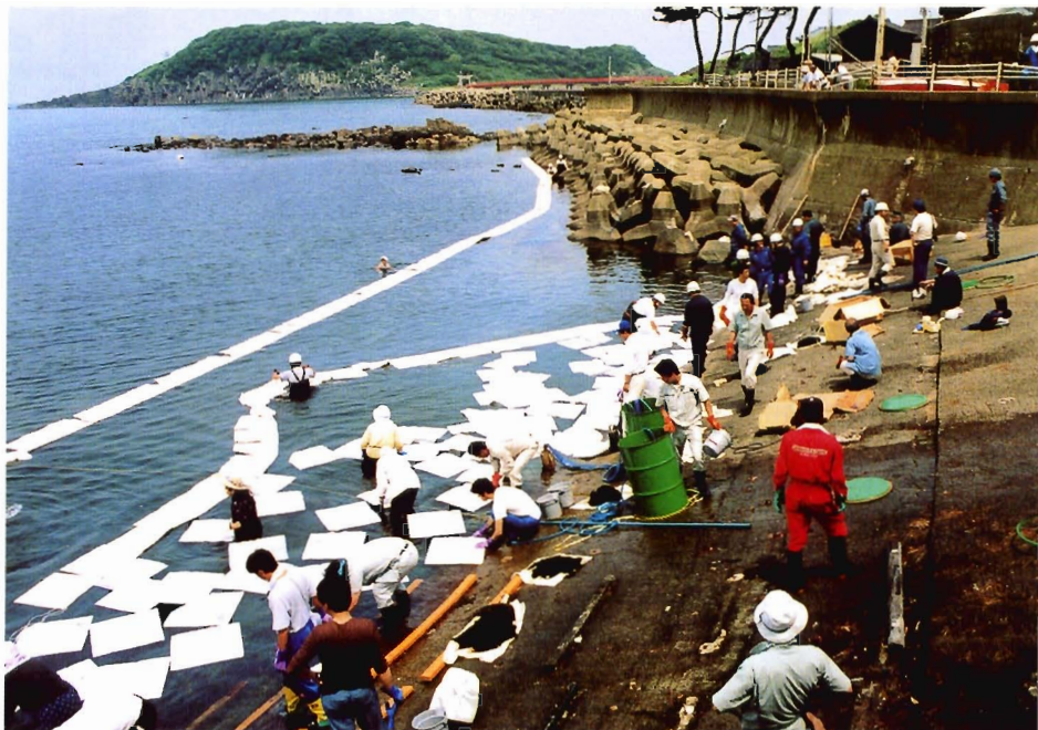
海岸に漂流している液状油の回収作業
