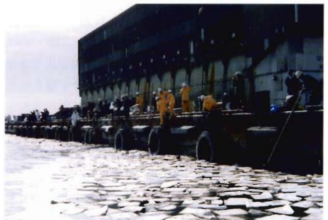
写真2 岸壁での油回収・清掃作業
