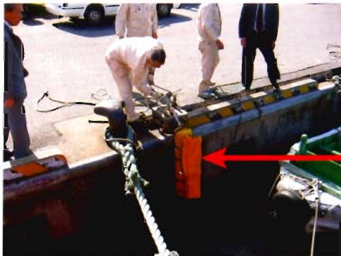
写真1 簡易スライディングジョイントを岸壁に取り付けているところ
