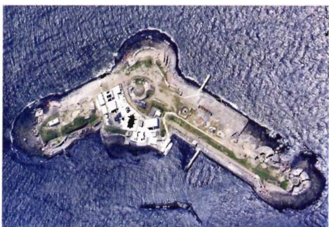
写真3 訓練所消防施設全景（東京湾第二海堡）
