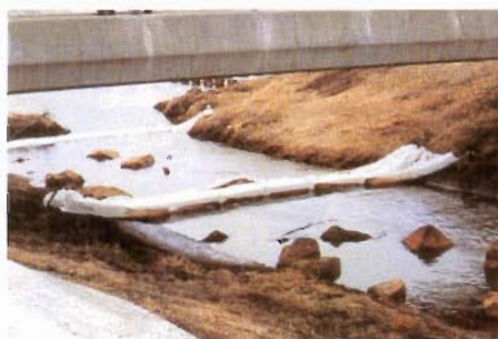
数ヶ所に設置することでより効果的に吸着できます
