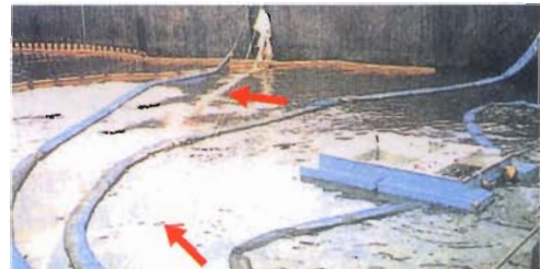
東扇島の船溜りへ流入した漂着油防除のためエンドレスロープ(矢印)を設置 油導入式浮枠をユニックで投入後2名で展張と追い込み回収した (ダイヤモンド・グレイス号、使用したオイルスキミングネット 計1,500m)
