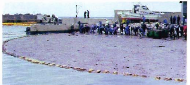
写真12 ボンボン状の油吸着材で港内の油を集めて引き寄せ回収、作業が簡単で後始末も容易、短時間で成果が上がった（ナホトカ・珠洲市）。
