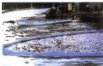
広域拡散油を護岸側へ追い込みオイルスキミングネット内外の波紋を比較すれば油の捕捉が明瞭(平成14年 油濁基金講習会、香岐)
