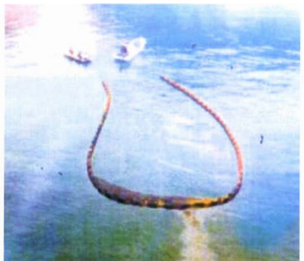
写真6 港内油の回収 小型船2隻でOF曳航凹部に油を集め岸壁で回収した 曳航速度、OFの形状により滞油性が決まる
