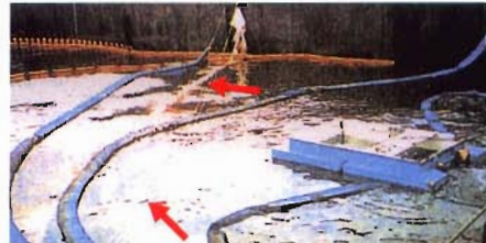
東福島の船溜りへ流入した漂着油防除のためエンドレスロープ(矢印)を設置 油導入式浮枠をユニックで投入後2名で展張と追い込み回収した (ダイヤモンド・グレイス号、使用したオイルスキミングネット 計1,500m)
