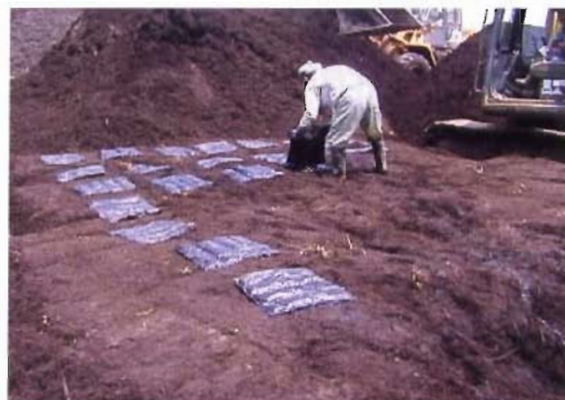
パイル断面に並べた吸着マットを被覆する様子
