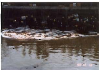
水面に散乱したシート型を長尺型で包囲し引き寄せました。
