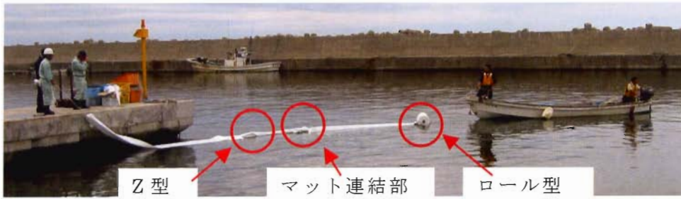
陸上および船上の作業員が長尺型油吸着マットの両端を持って海に展張
