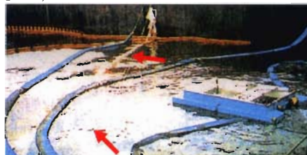
東扇島の船溜りへ流入した漂着油防除のためエンドレスロープ(矢印)を設置 油導入式浮枠をユニックで投入後2名で展開と追い込み回収した (ダイヤモンド・グレイス号、使用したオイルスキミングネット 計1,500m)
