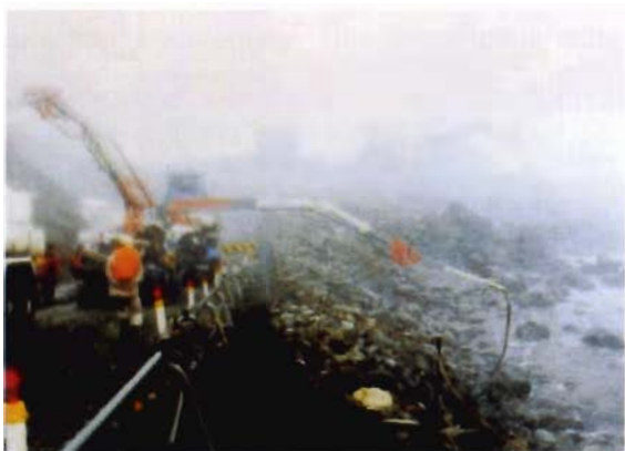
写真 11 コンクリートポンプ車 ポンプを逆転させ、危険な場所、障害物越え、夜間、遠隔で油を回収。
