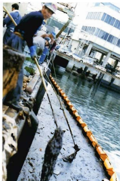
写真8 港内…非効率的、現在では強力吸引車で簡単に吸引回収できる
