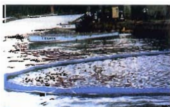
広域拡散油を護岸隅へ追い込みオイルスキミングネット内外の波紋を比較すれば油の捕捉が明瞭(平成14年 油濁基金講習会、香岐)
