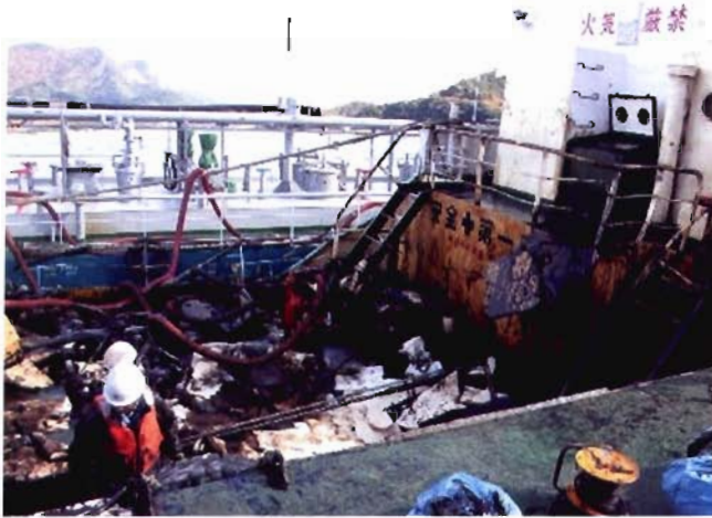
油抜き取り作業
