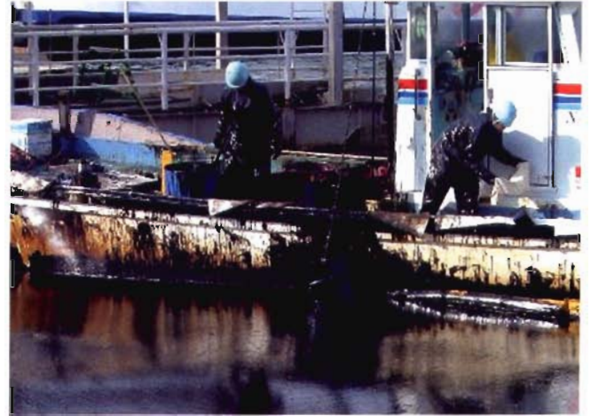
土庄港内の油回収作業
