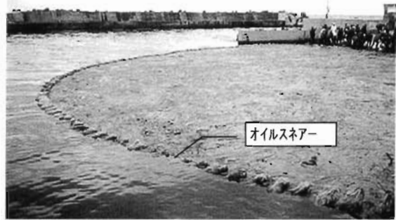
平成9年ナホトカ号事故現場 (オイルスネアーによるC重油の囲い込み)
