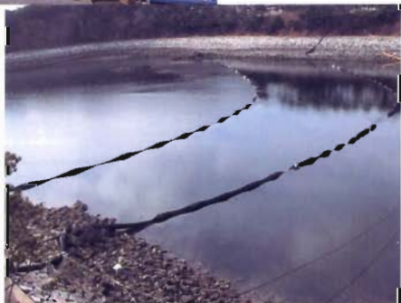
安眠島付近に設置されたOF等
