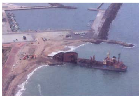
写真 17. 牽引作業の完了
