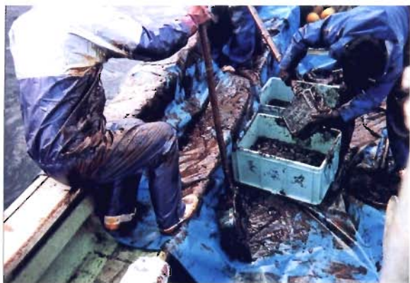
写真3 柄杓から容器に移す 油塊は粘性が高く、移すのに一苦勞
