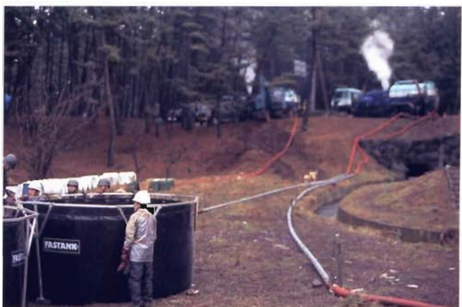
写真13 強力吸引車 延べ台数で800台以上が直接、間接に漂着油の回収に活躍した
