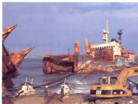
写真 16. 船尾部の牽引作業
