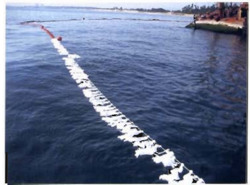
写真10. 油防除資材の展張
