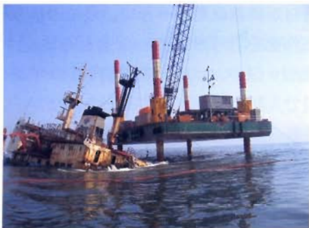
写真6. SEP台船による撤去作業
