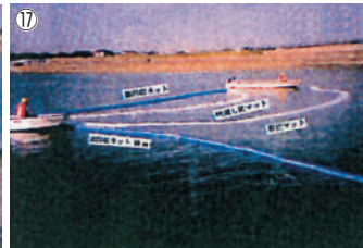
写真17 突堤・岩場から放水により剥離した浮流油を油回収ネット等で回収
