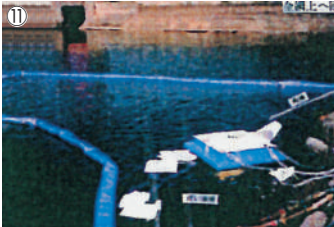
写真11 油回収ネットで追い込んだ厚い油層の中へ油回収浮枠を投入し、杓で油水を汲み入れ、又小片マットを浮枠上の金網に入れ一括回収。
