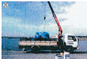
写真19 ユニック車クレーンまたはホークリフトにより1巻で護岸上のビニールシートに上げる。
