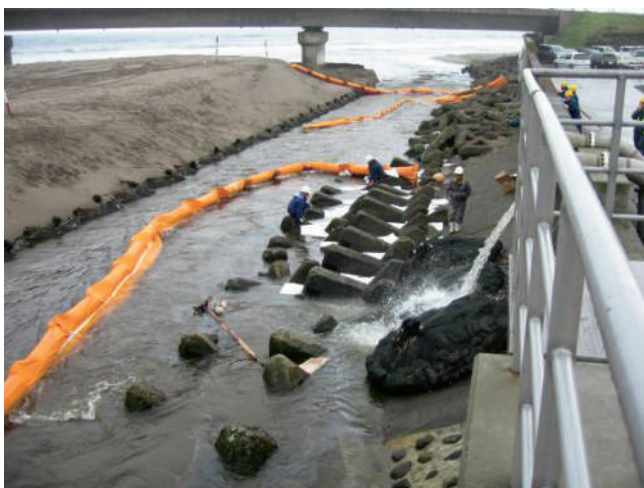
写真12 油は水路から水門を経て南部陣屋川へ B型OF3通りに地元消防により展張
