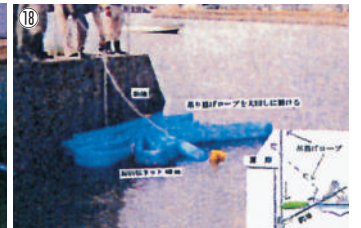
写真18 油回収ネット40mを護岸上から鉤棒により2名で折畳み、吊揚げロープを大回しに掛ける。
