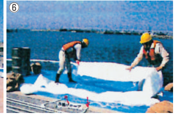
写真6 ビニールシートの吊揚げロープ上に折畳みながら2名で回収。
