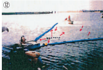
写真11 油回収ネットで追い込んだ厚い油層の中へ油回収浮枠を投入し、杓で油水を汲み入れ、又小片マットを浮枠上の金網に入れ一括回収。
