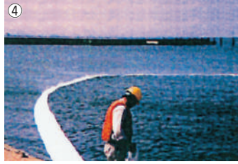
写真3-4-5 広域拡散油を包囲し、護岸前面へ追い込む。
