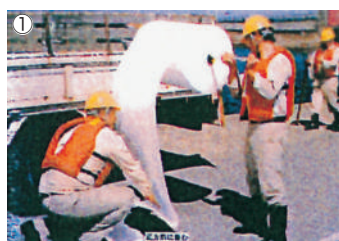
写真1-2 带状マットをZ状に折畳み、切断後固く縛り連結。
