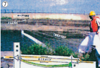
写真7-8 エンドレスロープを対岸へ展張し、帯状マットで浮流油を包囲回収。
