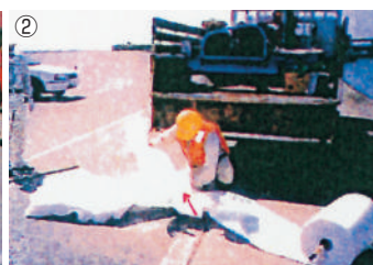
写真1-2 带状マットをZ状に折畳み、切断後固く縛り連結。
