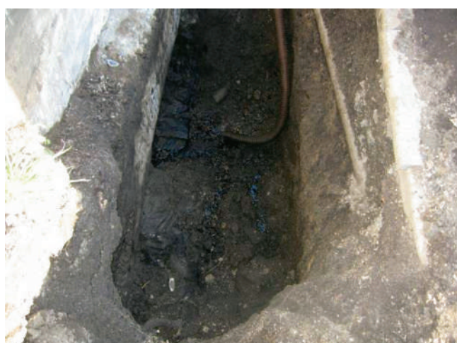
写真6 掘削箇所・滲み出る油分を吸引中
