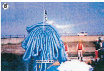
写真19 ユニック車クレーンまたはホークリフトにより1巻で護岸上のビニールシートに上げる。
