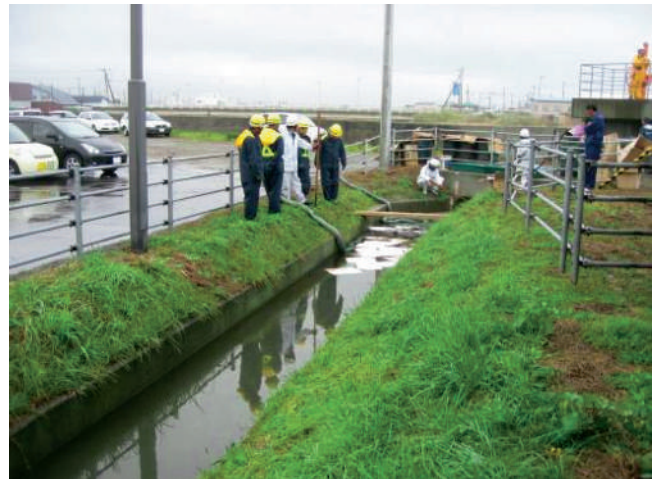
写真8 水路 水門付近の堰
