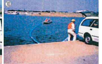
写真9-10 油回収ネットをライトバンから引き出し、船外機船2隻で浮流油を包囲しながら護岸へ追い込む。
