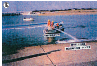
写真15-16 可搬式消防ポンプ〔約50kg〕を作業船へ積載し、突堤又は岩場から放水により付着油を剥離し海面へ追い出す。
