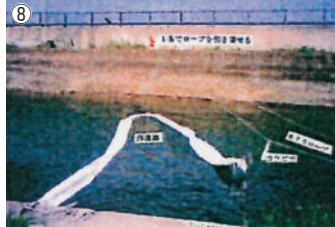
写真7-8 エンドレスロープを対岸へ展張し、帯状マットで浮流油を包囲回収。
