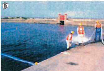
写真15-16 可搬式消防ポンプ〔約50kg〕を作業船へ積載し、突堤又は岩場から放水により付着油を剥離し海面へ追い出す。
