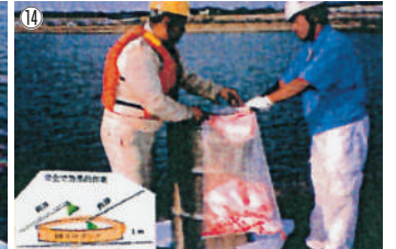
写真14 3.9m直径の組立タンク内の厚い油層を小片マットで回収しビニール袋内へ入れる。
