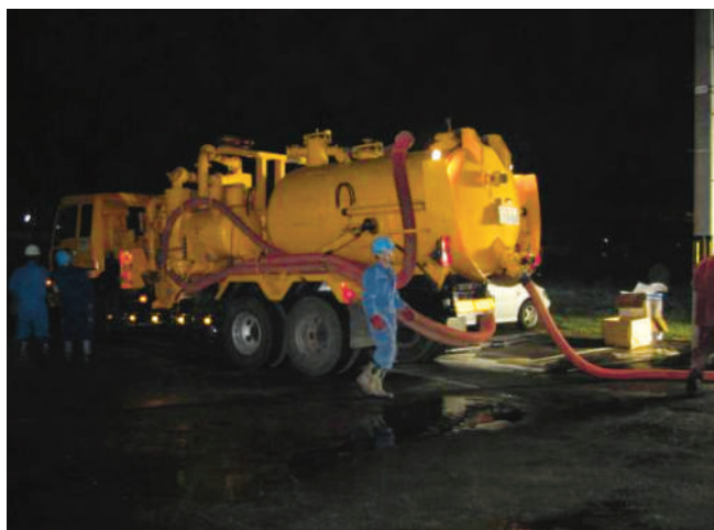
写真3 雨水枡内の強力吸引車による油水吸引
