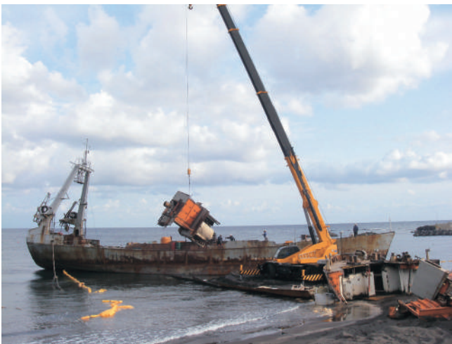
【解体作業 H20・10】
