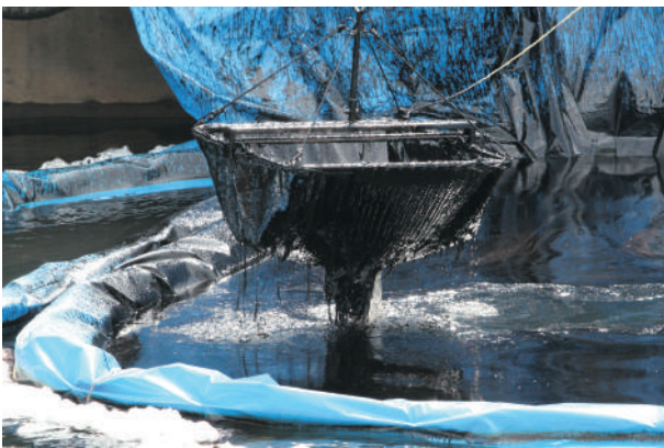
引き揚げて排水
