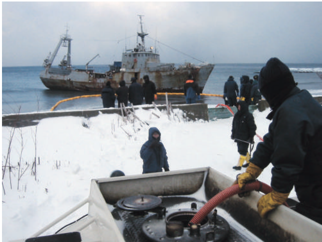
(燃料油抜取り作業 1月10日)
