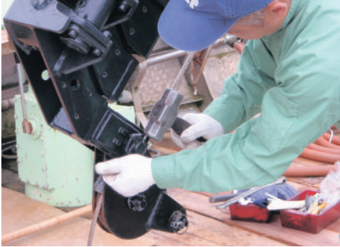
ヒアブクレーンの先端部分の取り外し
