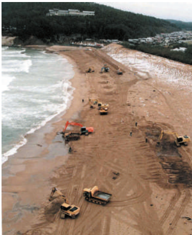
平成 9 年 1 月 重機による回収作業（片野海岸）
