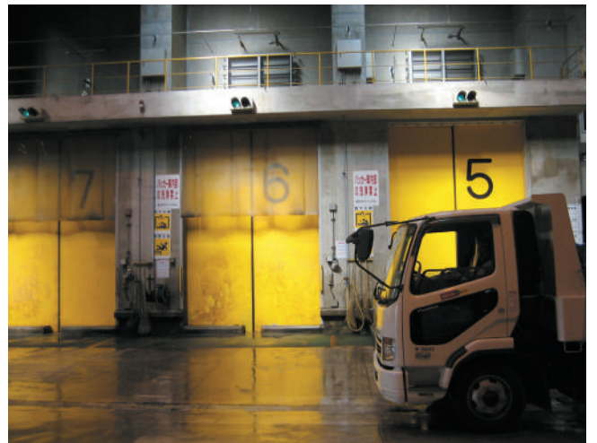
廃棄処理施設の内部
