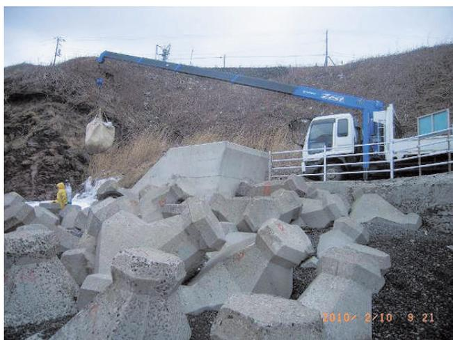
写真23 ユニック車によるフレコン回収
