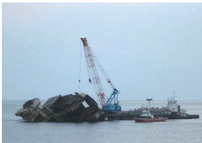
写真7 撤去作業の再開 H22.3.12 撮影
