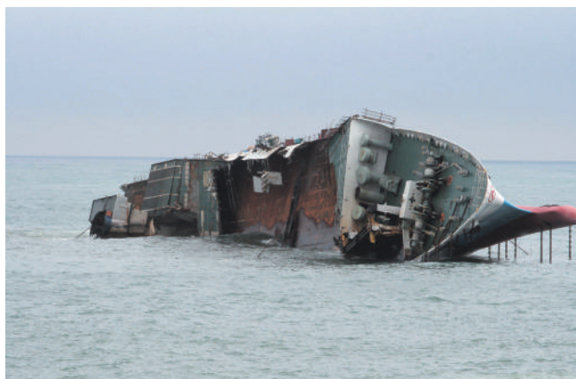
写真5 上部構造物の落下 H22.3.5 撮影
