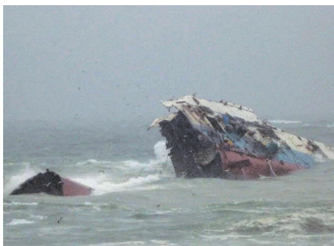
写真6 船首・居住ブロックの崩壊 H22.3.9 撮影
