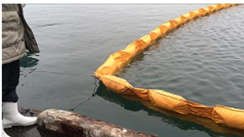
\*重錘を投入する写真ではありませんが、このようにOFの一部を岸壁側に引き寄せ、OF外側に重錘を垂らし、OFと岸壁の間に隙間が空かないように係止します。漏油を防ぐためです。
