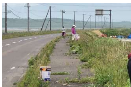
写真④ 車両が行き交う道路沿いでの作業の様子
