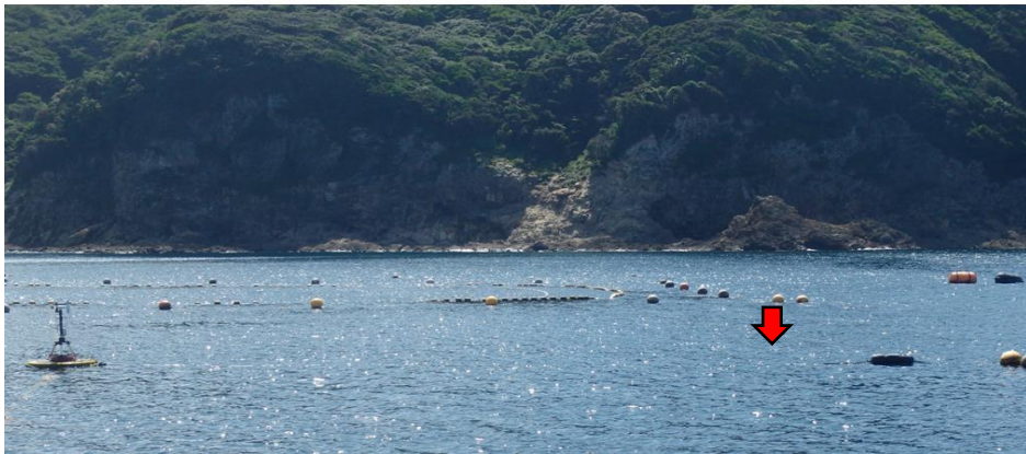
図 3.11 R4-2 型の設置状況 R4-2 型(図中➡、錨網と海洋観測ブイに固定)
