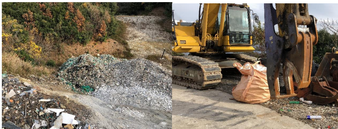
図 2.7 島内にある最終処分場と処分用の重機
