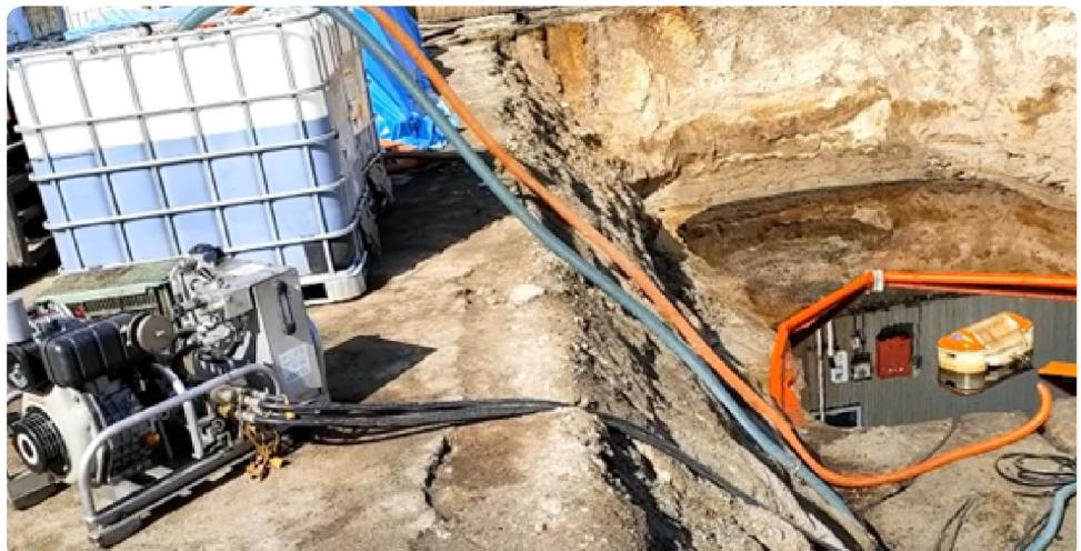
図24 ピットからくみ上げた水（タンク入り）を浄化槽に入れて水路に排水
