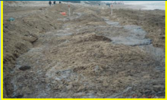
図14 油は穴を掘って溜められた。
