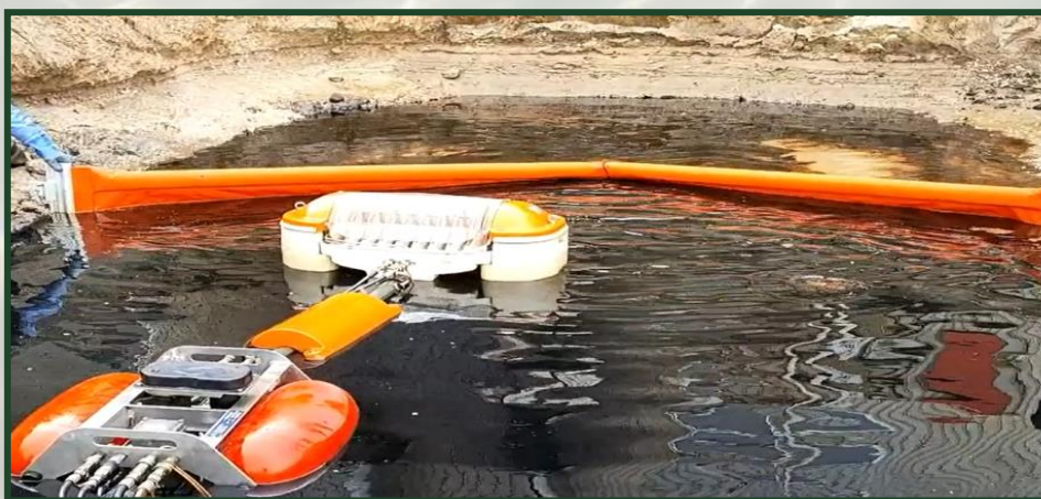
図7 回収装置（バイコマコマラ7型）
