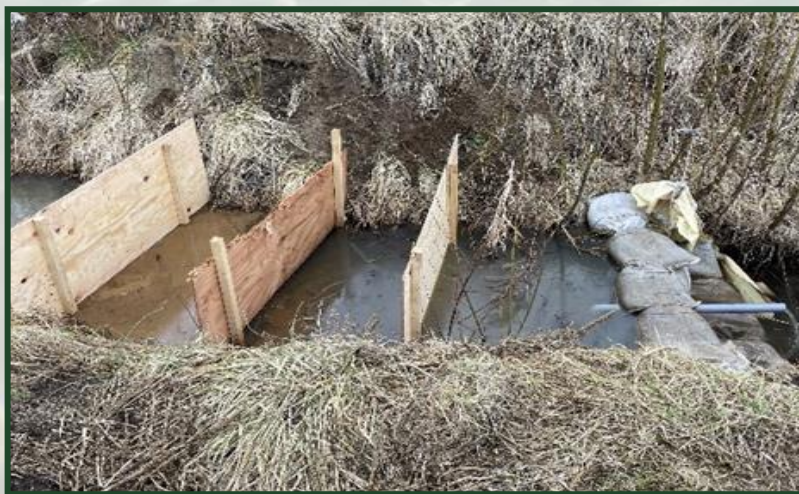
図8 コンパネと土嚢堰
