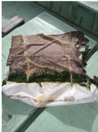
図 2-2-8 崩壊したフロートカバー
