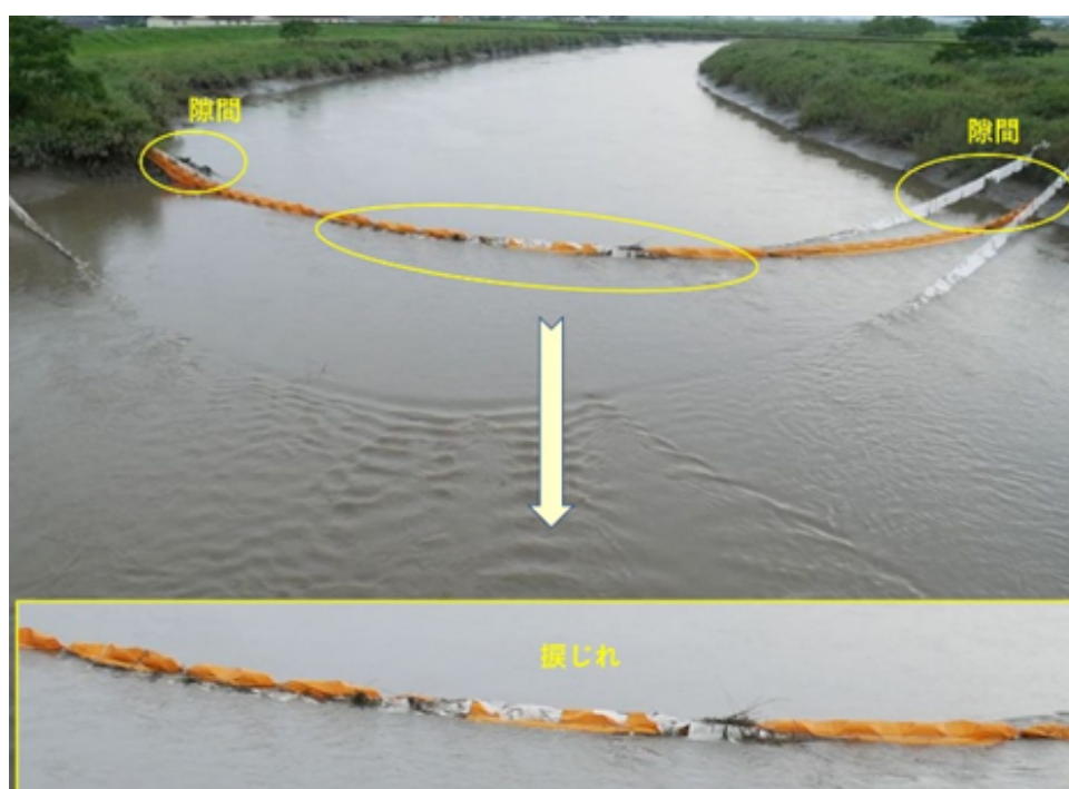
図7 六角川OFの隙間と捻じれ
