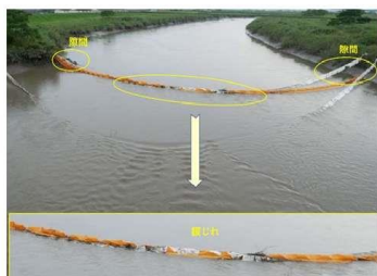
図7 六角川OFの隙間と捻じれ
