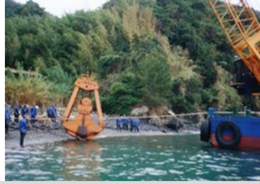
左：クレーン台船システム（グラブ船、押船、ボックスバージ、曳船等） 右：バケットグラブ（容量4m 3 ）で高粘度化した油を回収
