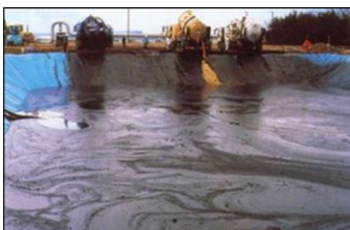
N号事故で回収した油を一時保管するために急造したピット（容量2,700m 3 ） このようなピットを各地区に建設した。
